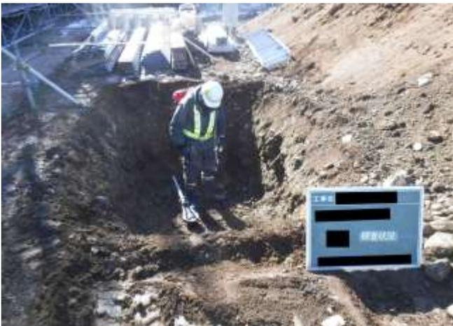
金属探知器による探査
