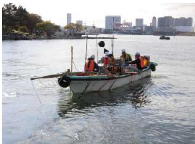
海や河川での磁気探査は、FRP製の探査船を用います。水深の深い区域は、専用のFRP台船を使用した台船曳航方式で行い、水深5m未満の浅い区域では小型船の独航方式で行います。
